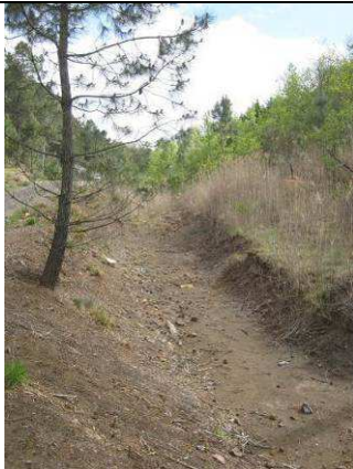
Photo 24 : Fossé collecteur des eaux d'exhaure du dépôt de résidus de traitement et des eaux ruisselant sur ce dernier (ruisseau d'Aiguesmortes)
