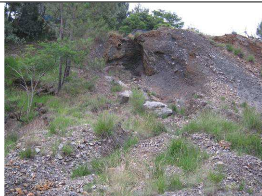
Photos 26 et 27 : Ravinements et exhaure sur le dépôt de stériles
