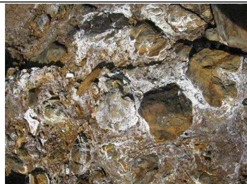
Photo 10 :Oxydation de surface (salpêtre)
