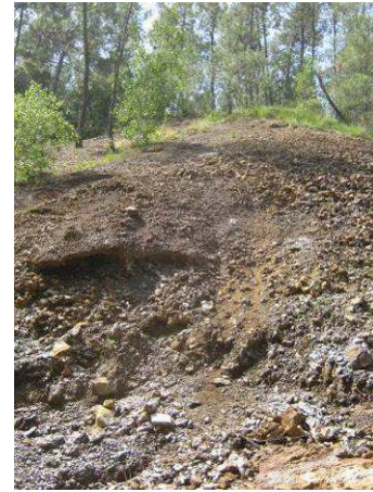
Photo 8 : Verse de stériles (roches minéralisées + scories) au droit de l'ancienne mine Joseph et signes de ravinement
