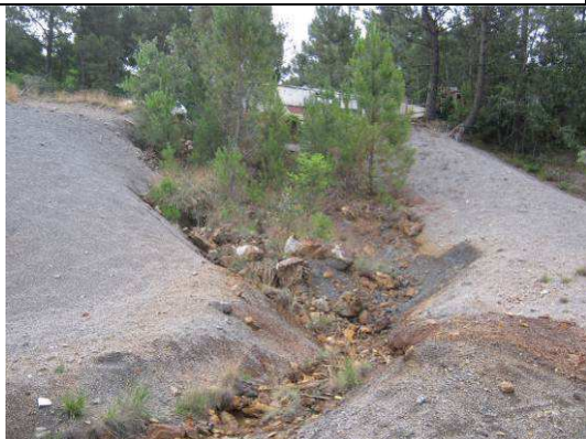
Photos 26 et 27 : Ravinements et exhaure sur le dépôt de stériles
