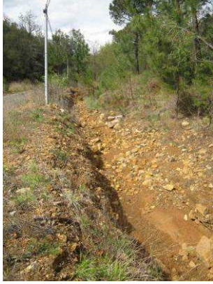
Photo 28 : Fossé collecteur des eaux ruisselant sur le dépôt de stériles (ruisseau d'Aiguesmortes)
