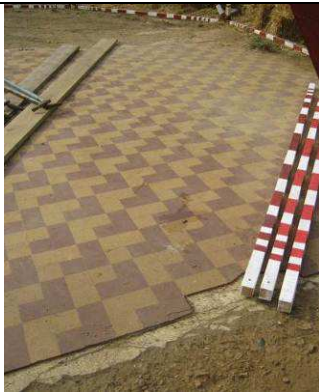
Photo 30 : Fondation de l'ancienne laverie
