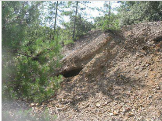
Photo 34 : Instabilité au niveau des dépôts de stériles (zone cross) (coordonnées Lambert 3 : X=728 230 ; Y=194 600)
