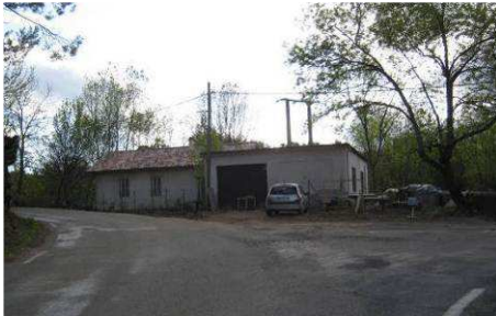
Photo 15 :Garage de la mine en bordure de la D133
