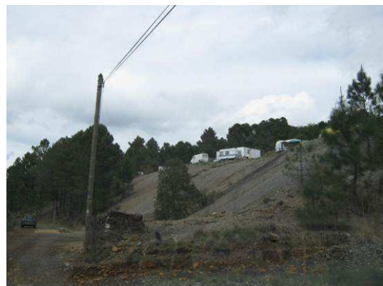
Photo 25 : Dépôt de stériles en face du dépôt de résidus de traitement et habitats temporaires sur la plate-forme haute
