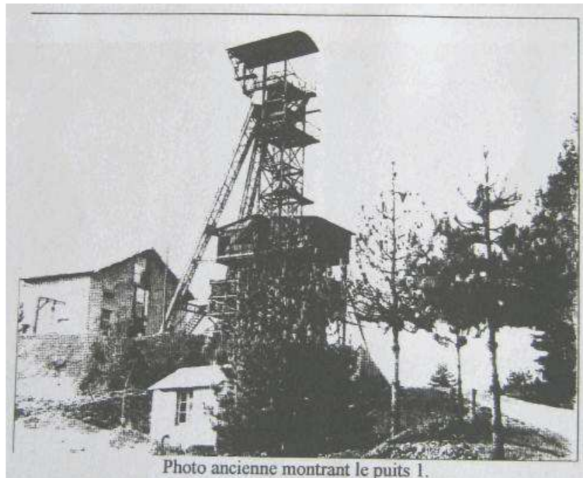
Figure 11 : Photographie ancienne du puits n°1 de la Mine de la Croix de Pallières (date inconnue, source DREAL)
